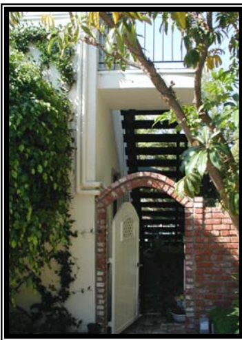
PVC flexible fue usada para esconder las pipa detrás de esta arca de ladrillo.
