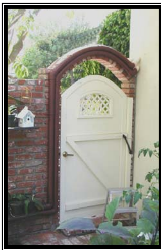
PVC flexible fue usada para esconder las pipa detrás de esta arca de ladrillo.
