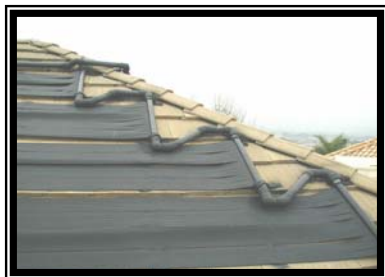
Conectando los encabezados de un sistema pirámide.
